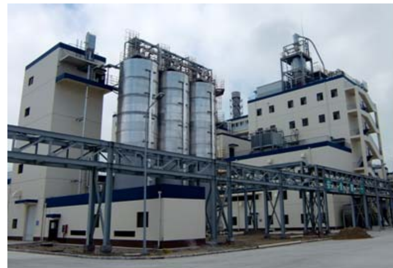
三大雅精細化学品(南通)有限公司(SDN)の増設設備 ('11年6月稼働)
