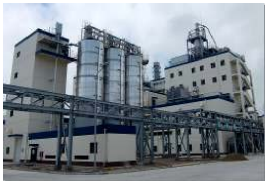
SDN増設設備
