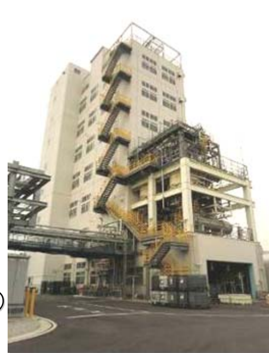
パイロット設備を増強する 衣浦工場AOAプラント
