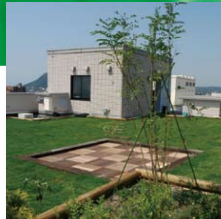
屋上緑化の土壌保水剤に
