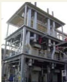
名古屋工場のカスタービン コージェネレーションシステム (省エネができる熱電併給システム)
