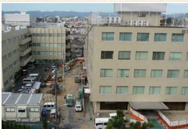
免震化工事中の本社棟本館
