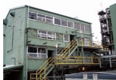
サンヨーケミカル・アンド・レジンズLLCの潤滑油添加剤製造プラント
