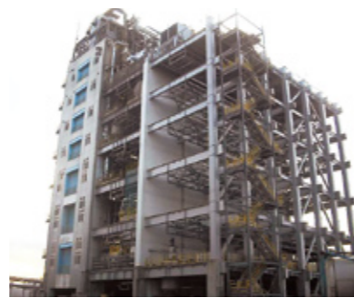
鹿島工場の潤滑油添加剤製造プラント
