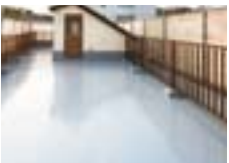
屋上防水材に
