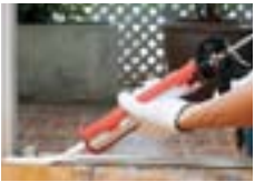
シーリング材に
